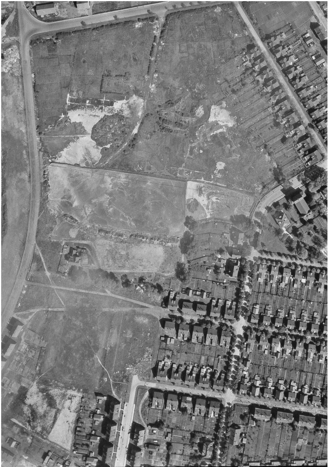
Abbildung 13: Orthofoto aus dem Jahr 1957 mit eingespülten Kraftwerksaschen; die vormaligen Klärbecken sind nicht mehr sichtbar (bereits durch Einspülungen überdeckt)
